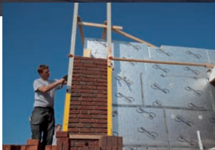
Harde isolatieplaten verdwijnen achter de gemetselde gevel.
